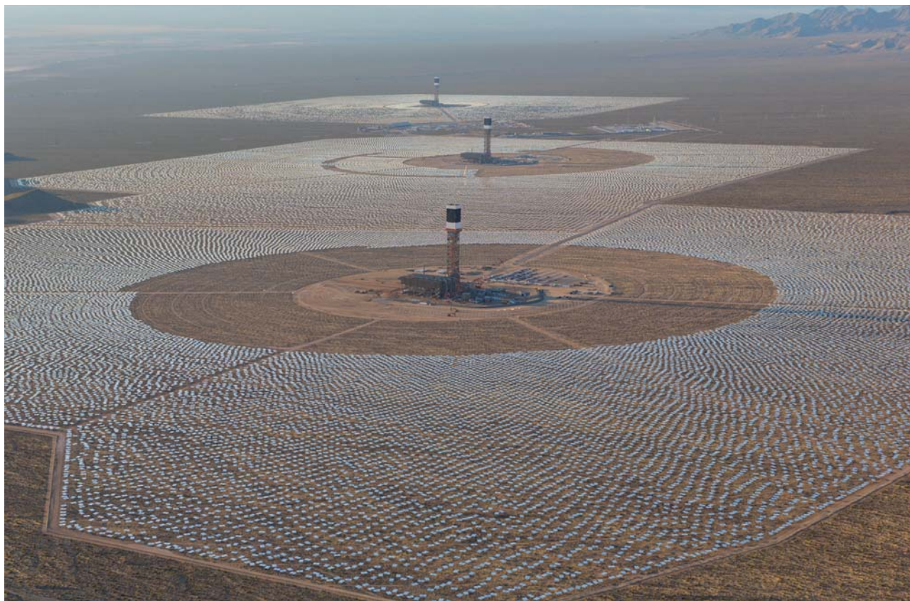
7. Ivanpah, il più grande impianto solare termico a concentrazione "a torre" mai costruito al mondo, entrato in funzione il 13 febbraio 2014.
